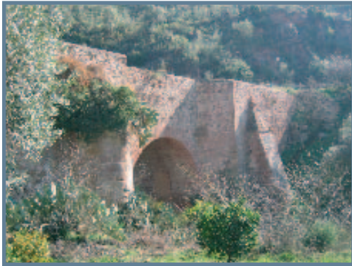
Puente Larga sobre el Río Campanillas. Almogía.
