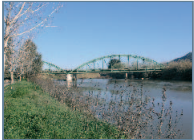
Puentes de hierro de Cártama Estación. Foto: Ayto. Cártama
