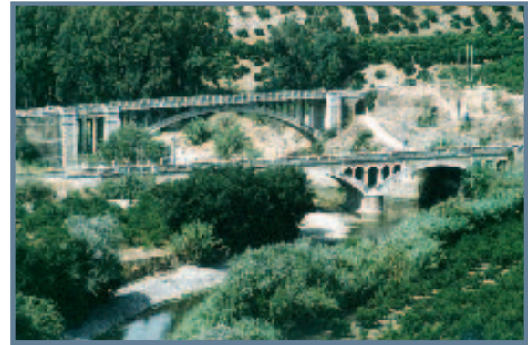
Puentes sobre el Río Guadalhorce. Pizarra.
