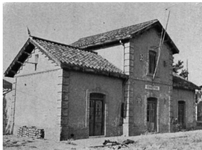
Antigua estación de Renfe
